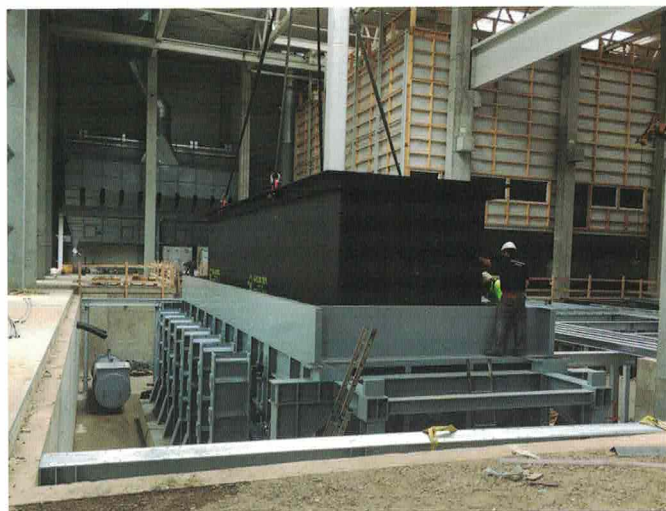
Bild 2. Der imposante Verzinkungskessel wird eingebaut.
